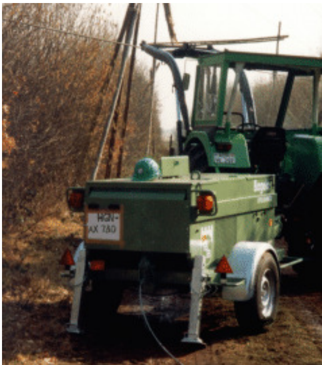
KW 3F als Stockwinde beim Rückbau einer 110 kV-Freileitung
