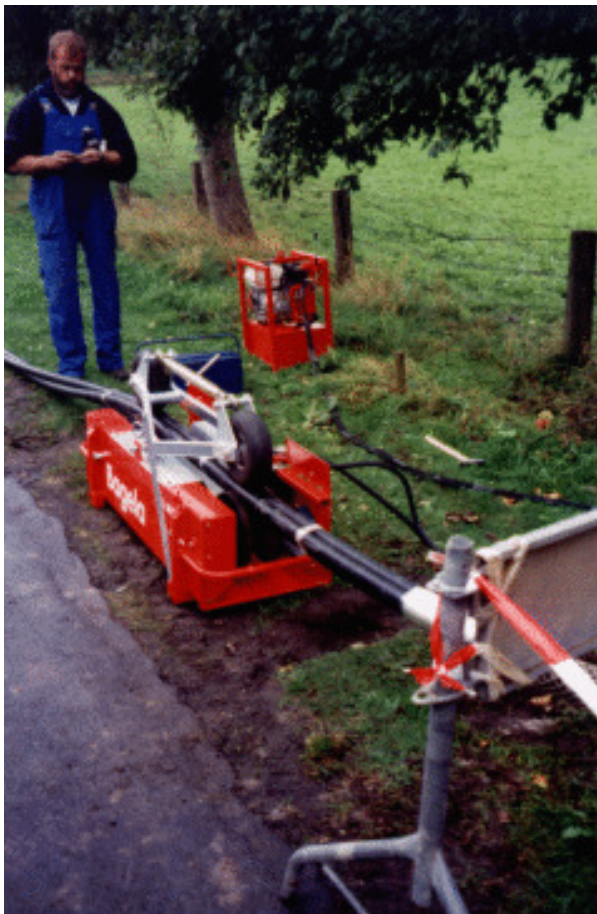
Verlegung von 3 x Einleiterkabeln 30kV
