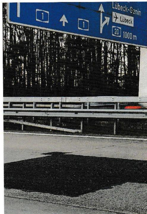
Bild 1: Die Idee ist, schadhafte Stellen auf der Betonautobahn mit Asphalt zu verfüllen, um dann später eine vernünftige Sanierung mit Beton durchführen zu können, wenn es die Witterungsverhältnisse wieder zulassen
