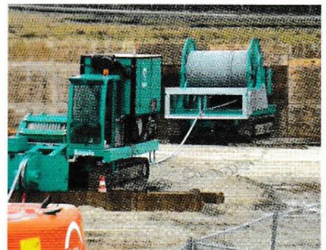
Kein Problem beim Kabeleinzug: Die Rohrsanierungswinde RW 100 von Bagela hat eine maximale Zugkraft von 1.000 kN. | Foto: 50Hertz
