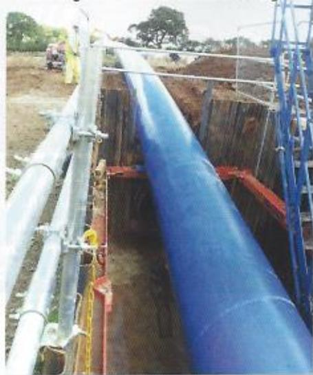
wandige Rohr ohne Zwischenraum direkt an das Alrohr und kann dessen Stabilität nutzen. Der Hauptauftragnehmer für dieses Projekt ist die Firma Balfour Beatty. Die Wasserversorgung muss während der gesamten Bauzeit garantiert sein, deshalb wird immer nur an einer Rohrleitung gearbeitet.
