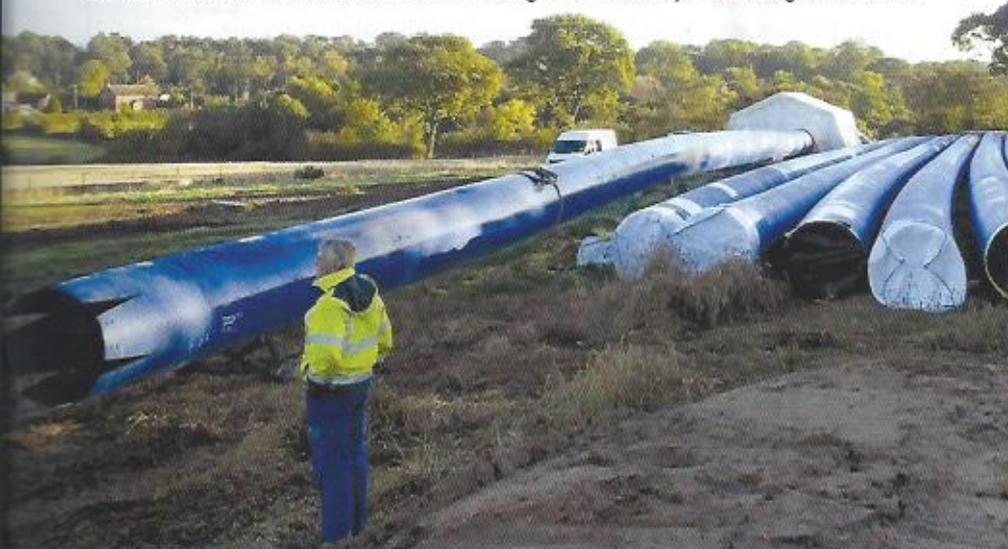
Die einzuziehenden PE-Rohre SDR 51 haben vor der Reduzierung einen Außendurchmesser von 1030 mm.
