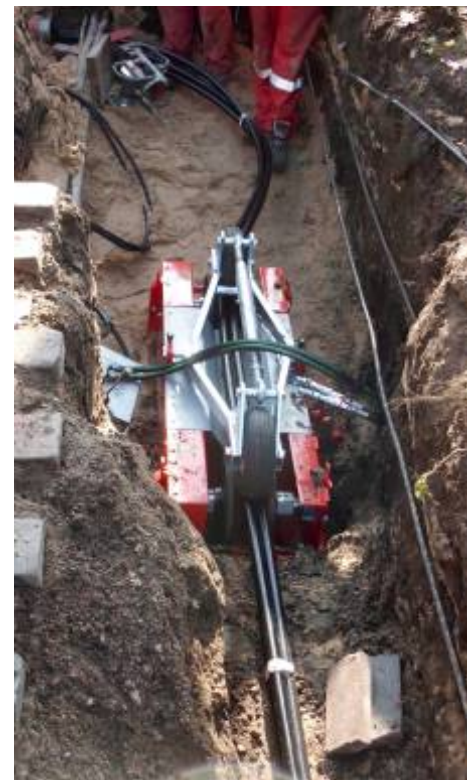
Verlegung von 3 x Einleiterkabeln 30 kV
